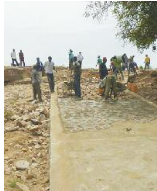
Construction de pistes au Mali
