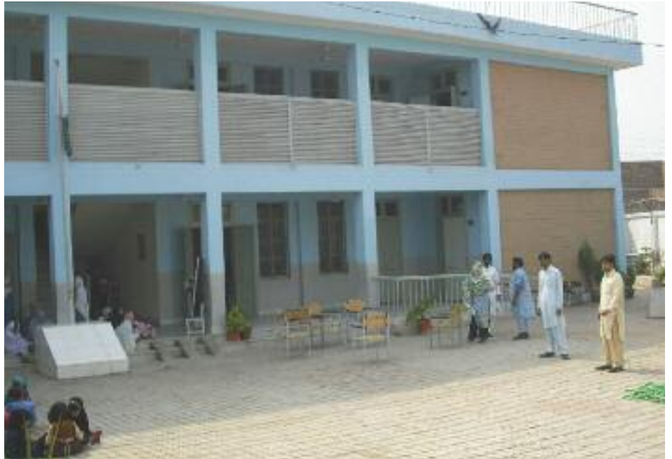
École primaire pour filles à Dag Bahsud, District de Nowshera : construction d'un bâtiment supplémentaire avec 8 classes, sanitaires et rénovation de la cour de l'école
