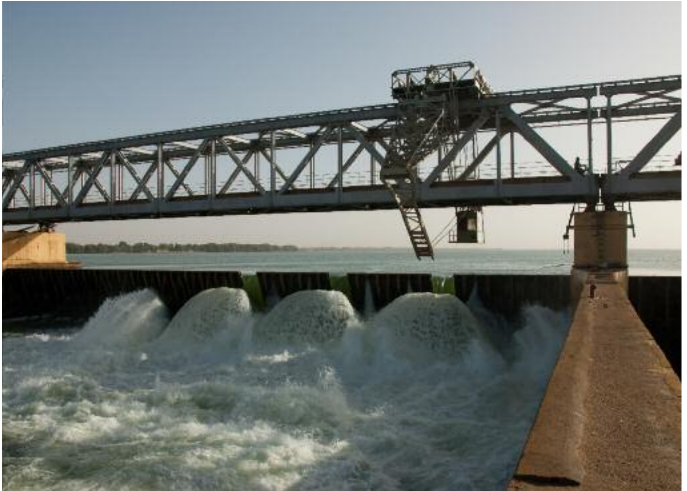
Ouvrage de Markala sur le fleuve Niger au Mali
