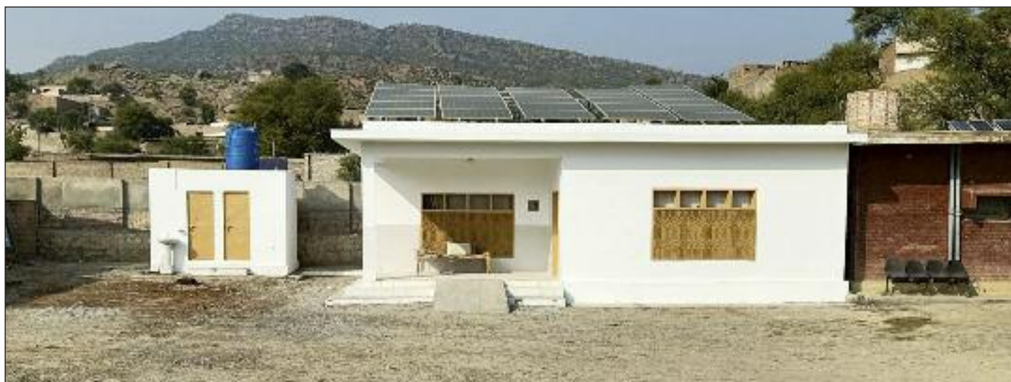
Installations solaires des unités de santé primaire ©Omer Rasheed
