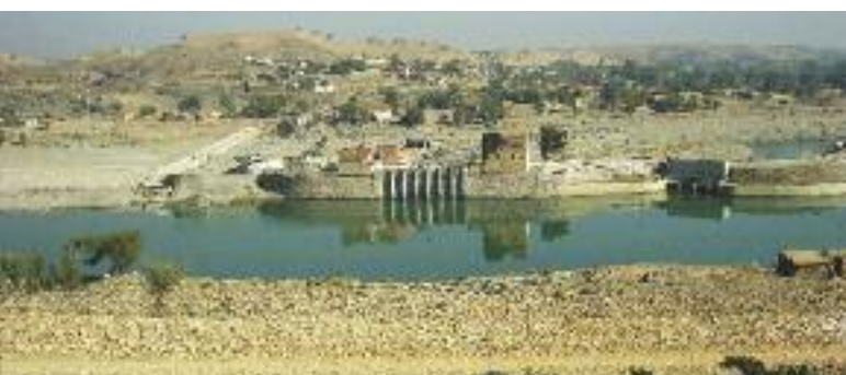
Prise d'eau pour une nouvelle zone d'irrigation le long de la rivière Swat
