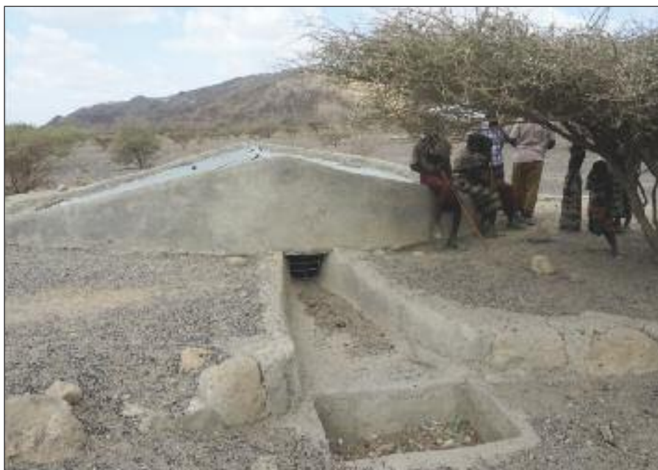
Infrastructure de récupération de l'eau dans la région d'Afar, Éthiopie
